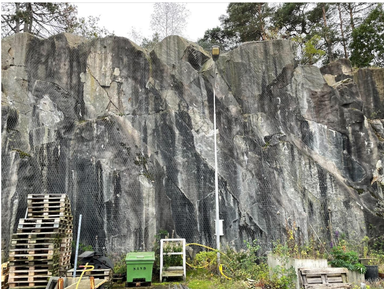
Figur 4 Vy mot sydväst. Befintlig bergskärning som ska loss hållas.
