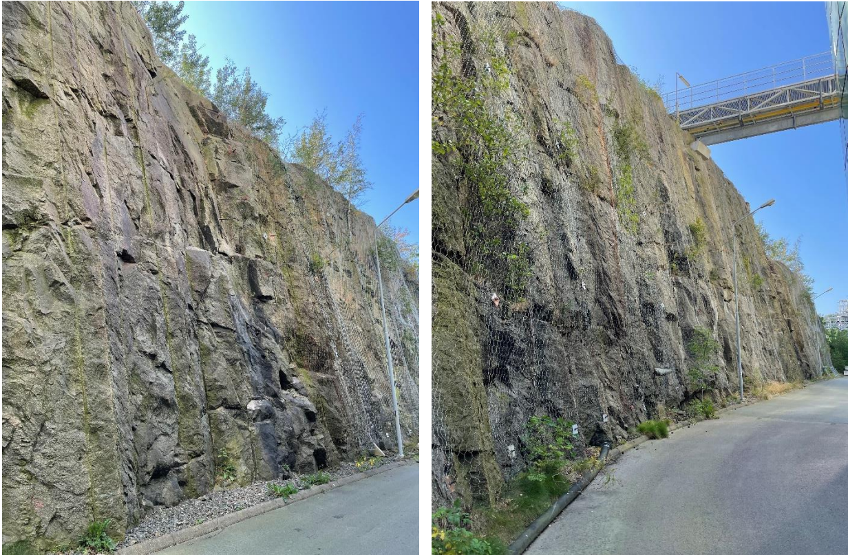
Figur 8 Befintlig skärning bakom rötkamrarna med brantstående sprickplan i nordnordvästlig-sydsydöstlig riktning.
